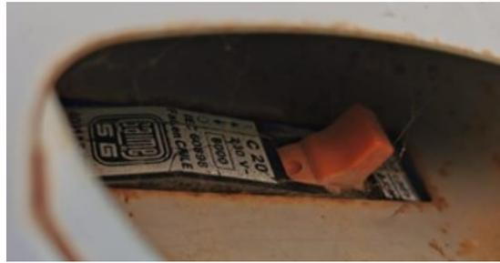
Fotografía 1 Automático ubicado en empalme de 20 Amper [A]
