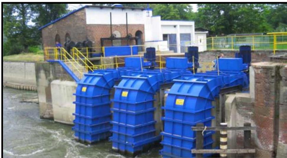
**Fig. 5.2 - Instalación con tres microturbinas de 100 kW TM10 de Mavel, equivalente a la del tipo propuesto como instalación en el proyecto El Taco de la Tabla 5.2**
