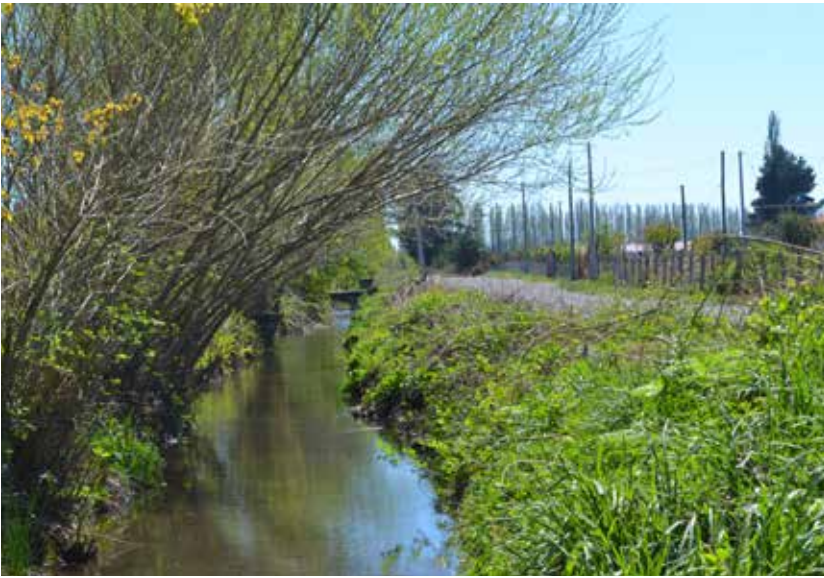
FIGURA 15. Canal San Francisco, región del Biobío.
