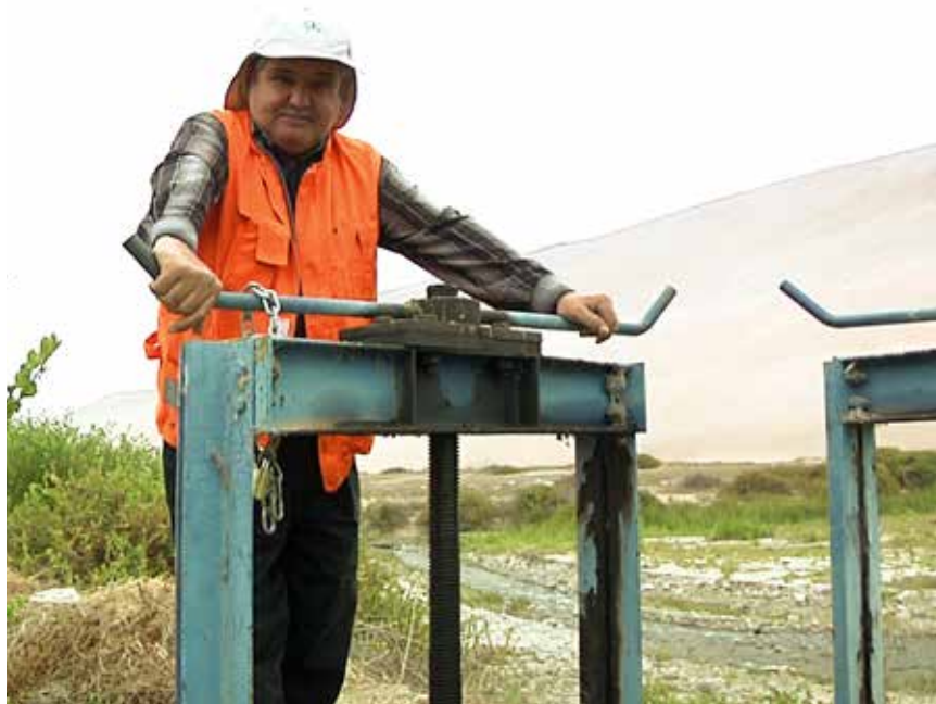
FIGURA 13. Celador verificando compuerta.
