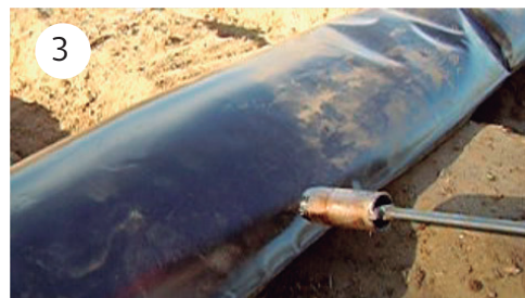
3) Con cilindro caliente hacer el orificio en la manga llena de agua.
