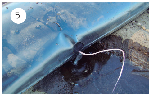
5) Compuerta semi abierta.
